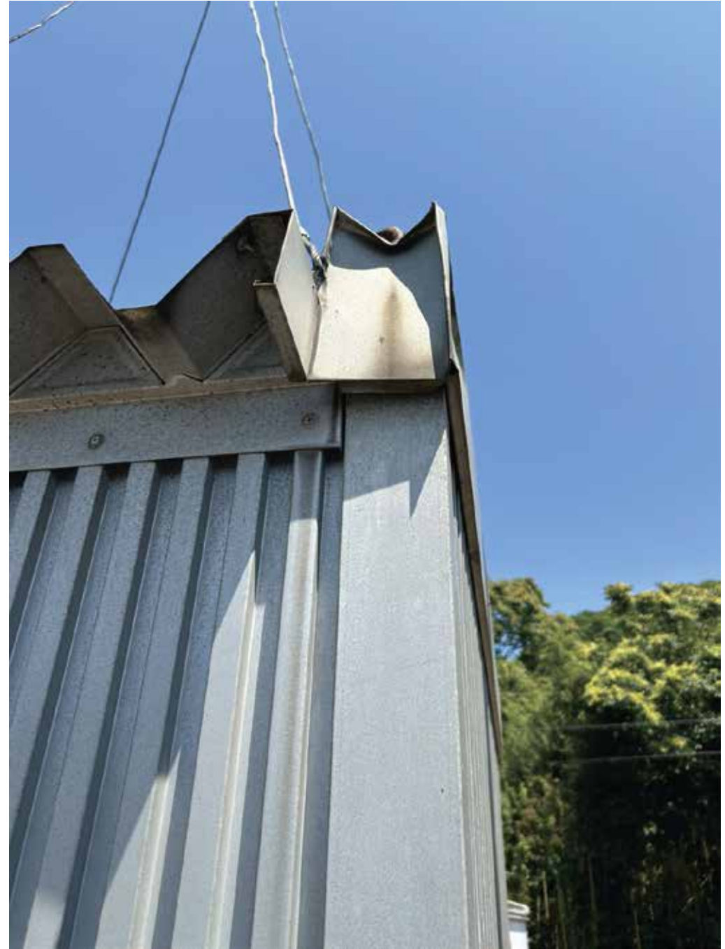
1坪シャッター倉庫U1463
