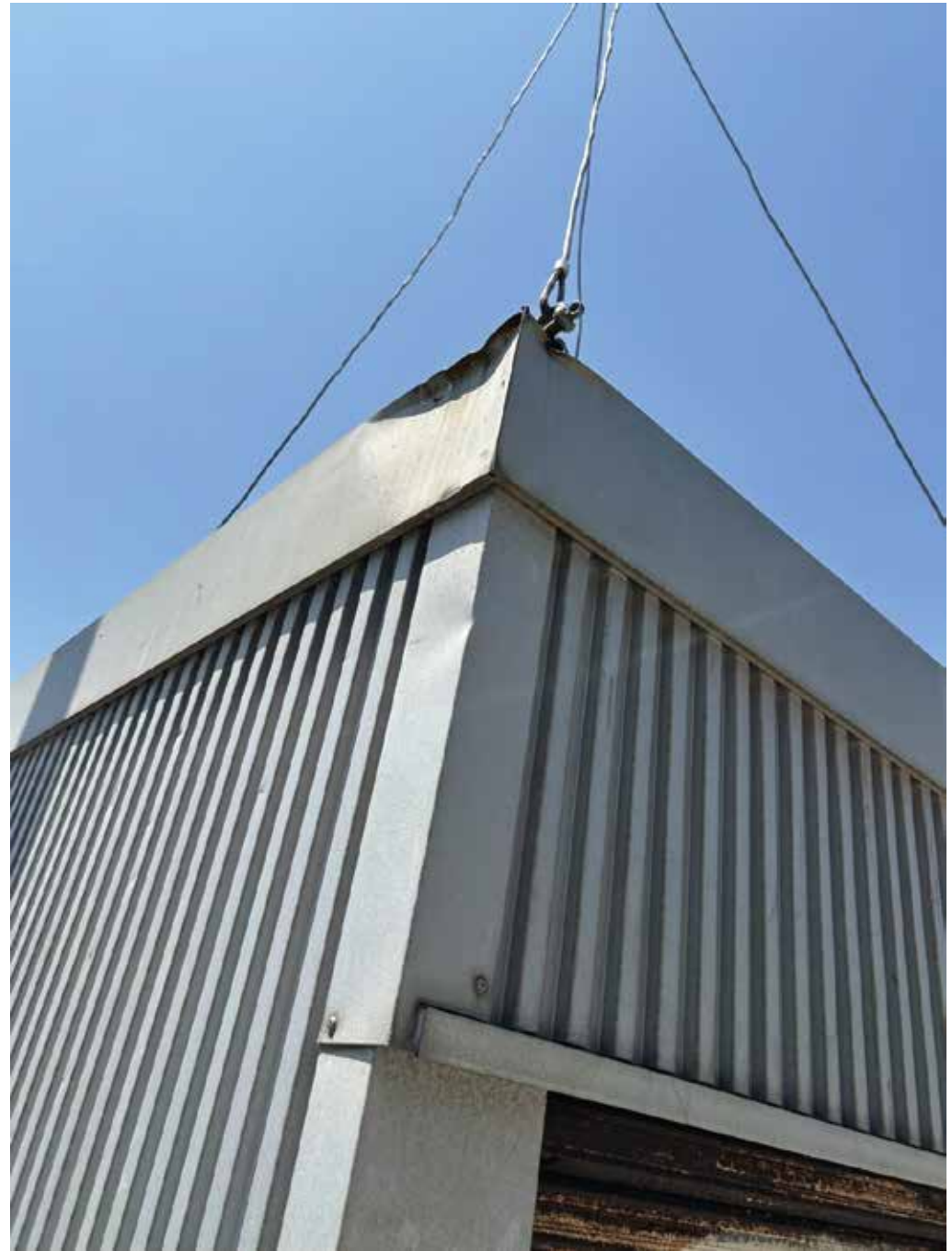
1坪シャッター倉庫 U1463
