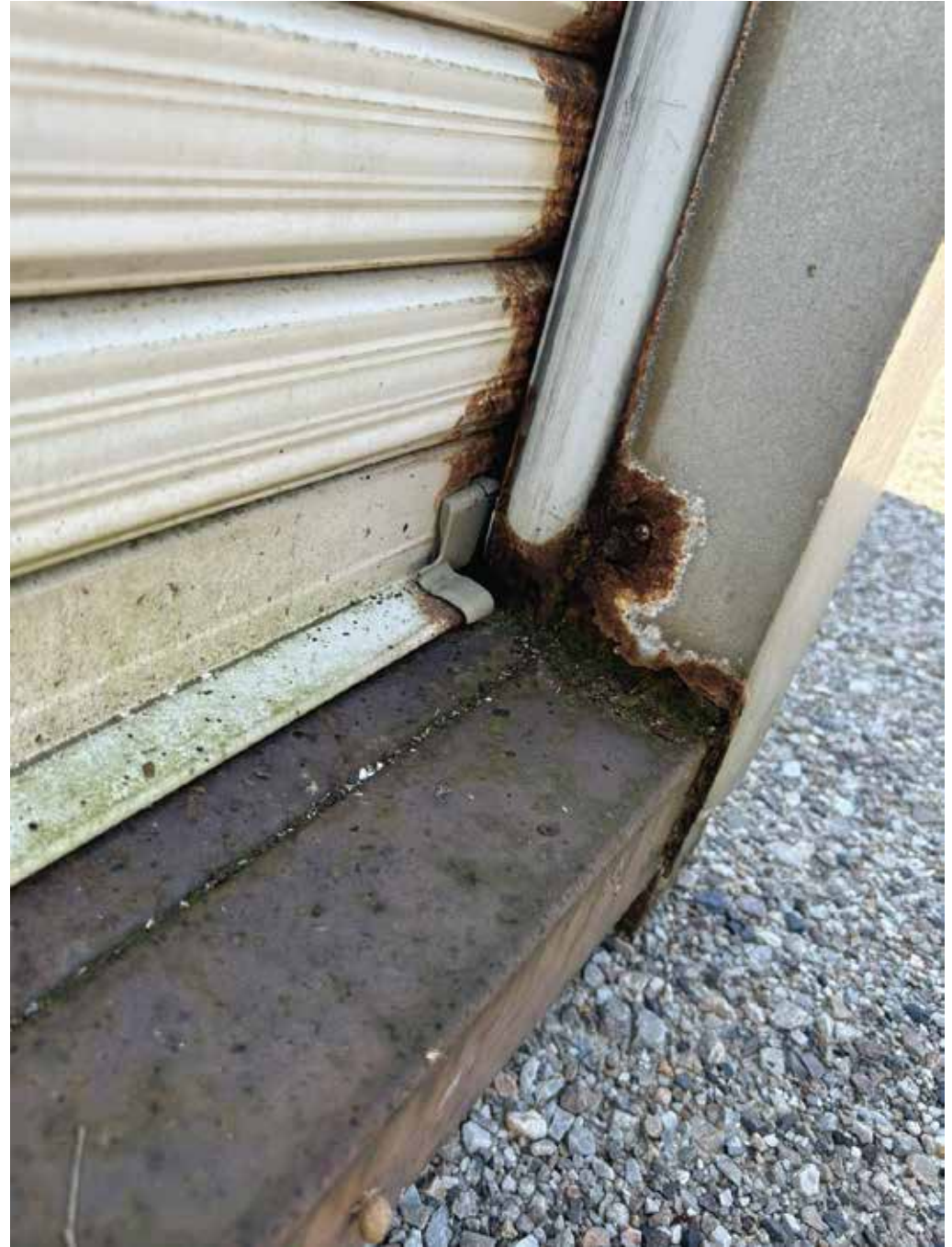
1坪シャッター倉庫U1463
