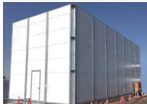
東京外郭環状道路現場
