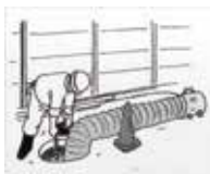
酸欠防止、ガス中毒防止、マンホールの換気、送風
