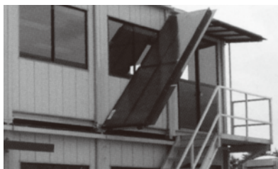
階段/W:900 X:2300 Y:2765 踊場/W:900 X:2300 庇 階段屋根/W:900 X:3300
