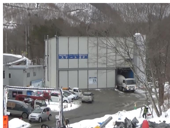
写真-3 スマートバッチャープラント外観
