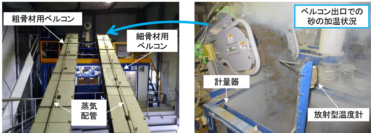
写真-1 蒸気による加温状況
